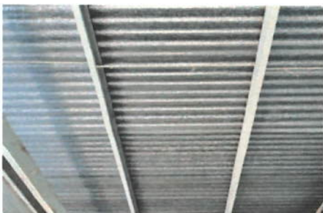
Foto1: CUBIERTA DE LAMINA
