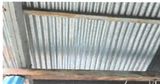
Foto 2: ESTRUCTURA DE TECHO
