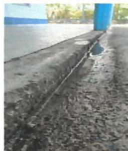
Foto 4: CUNETA DE CONCRETO
