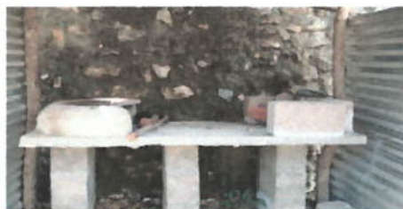
Foto 6: REPARACIÓN O SUSTITUCIÓN DE ÁREA DE COCINA
