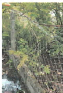
Foto 5: CERCO O MURO PERIMETRAL
